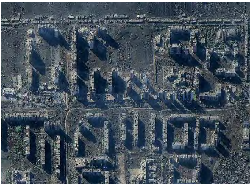
Figura 1.8 Immagine Satellitare dell'Area Urbana di Bakhmut, Ucraina, con Edifici Residenziali e Infrastrutture Gravemente Danneggiati dalla Guerra, 2026.
